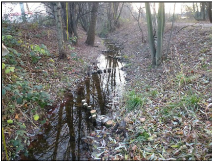
Abb. 4: Nach der Maßnahme: Initiierung von Strömungs- und Tiefenvarianz durch Buhnen, 16.12.2020
