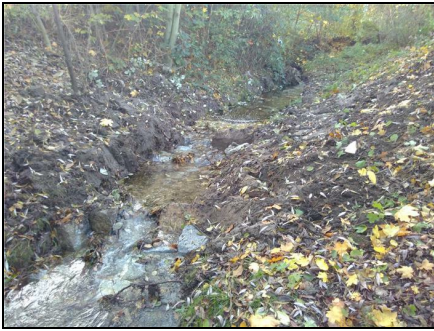
Abb. 3: Nach der Maßnahme: Verbesserung der Durchgängigkeit der Sohlrampe (Querbauwerk AKZ 13344) durch Sohlriegel und Steinschüttung, 13.11.2020
