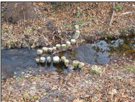
Abb. 5: Nach der Maßnahme: Strömungstrichter zur Initiierung von Strömungsdiversität, 16.12.2020
